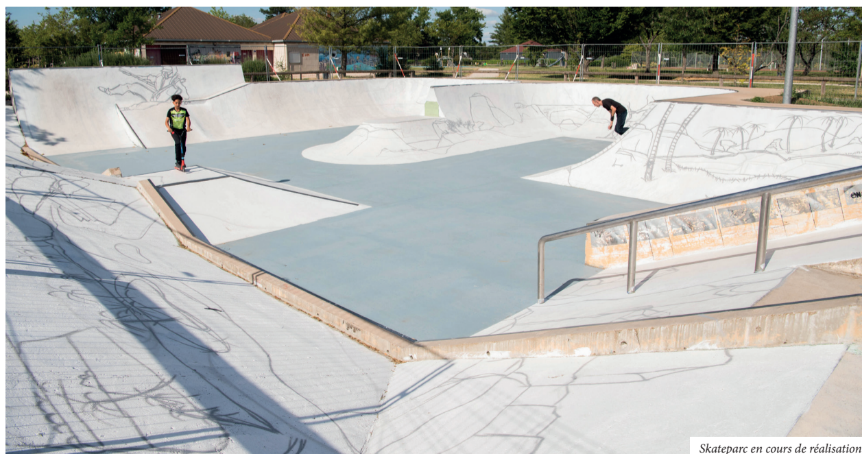
Skateparc en cours de réalisation
