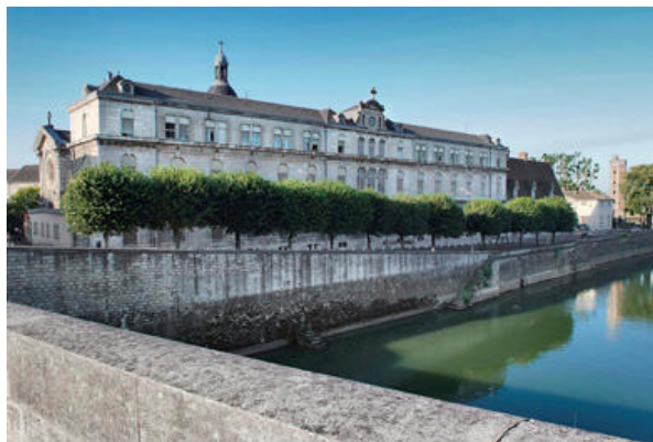
Vue actuelle des bâtiments hospitaliers en front de Saône (n°3 sur le plan en fin de point 2.1)
