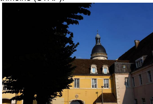
Vue actuelle des bâtiments du XVII ème siècle
