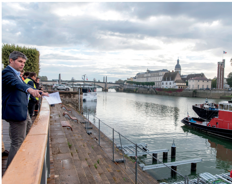
Sur le chantier de la deuxième phase des travaux au Port-Villiers
